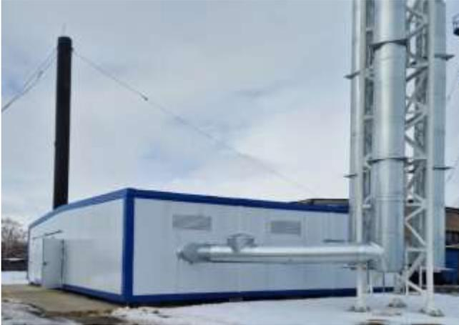
**Приобретение 2-х блочно – модульных газовых котельных, мощностью 4,0 МВт**
